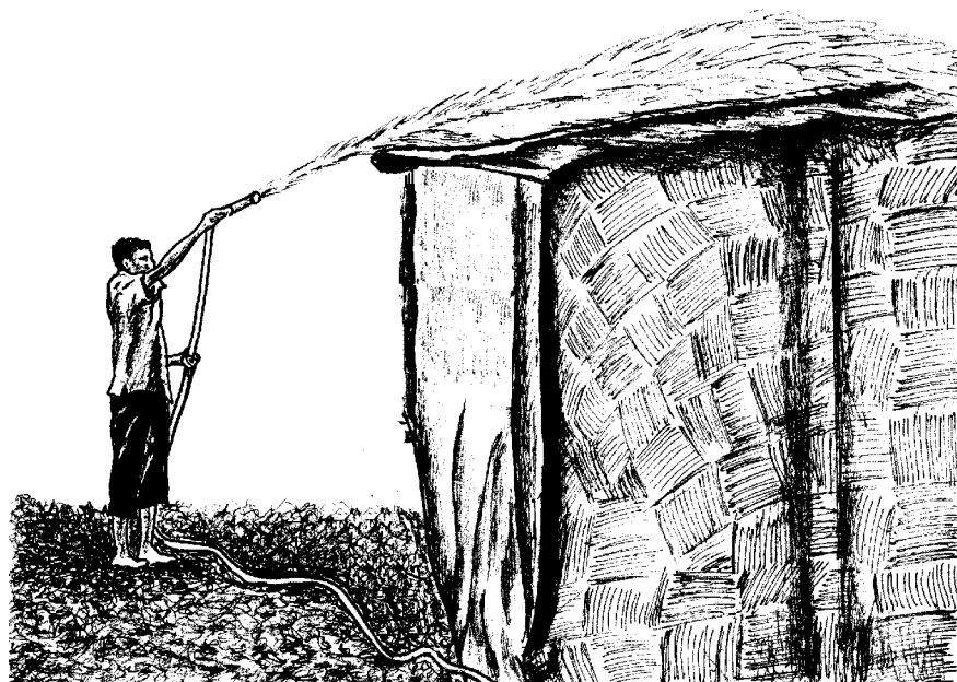
Figure 26 : Arrosage du tissu recouvrant le toit
